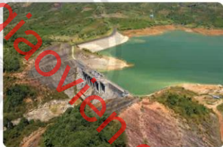
Hình 2. Nhà máy thủy điện Đông Nai 3 (Lâm Đồng)
