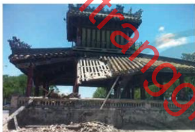
Hình 6. Mái Phủ Văn Lâu bị sập do thời gian tàn phá
